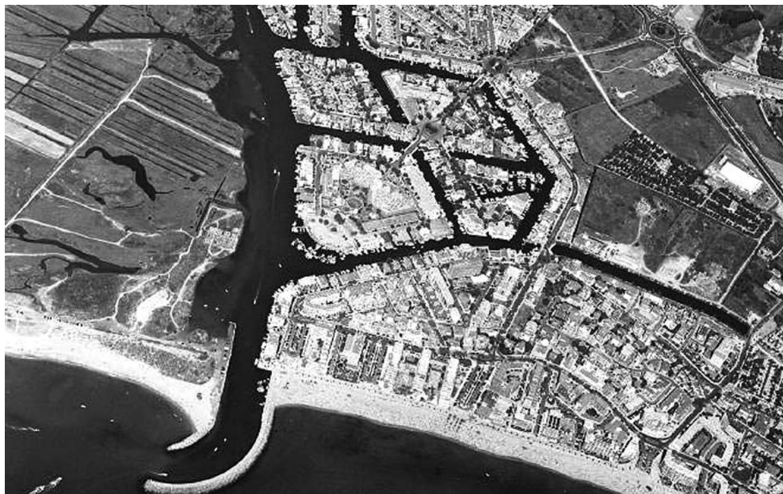
IMPULSAR EL PORT ESPORTIU. Amb aquestes obres, la Generalitat vol millorar la qualitat de les instal·lacions
